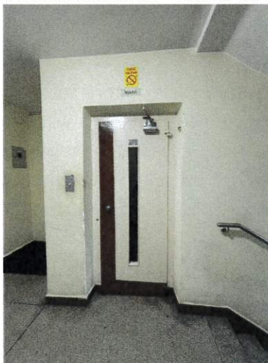
II klatka schodowa – ściana do windy:
