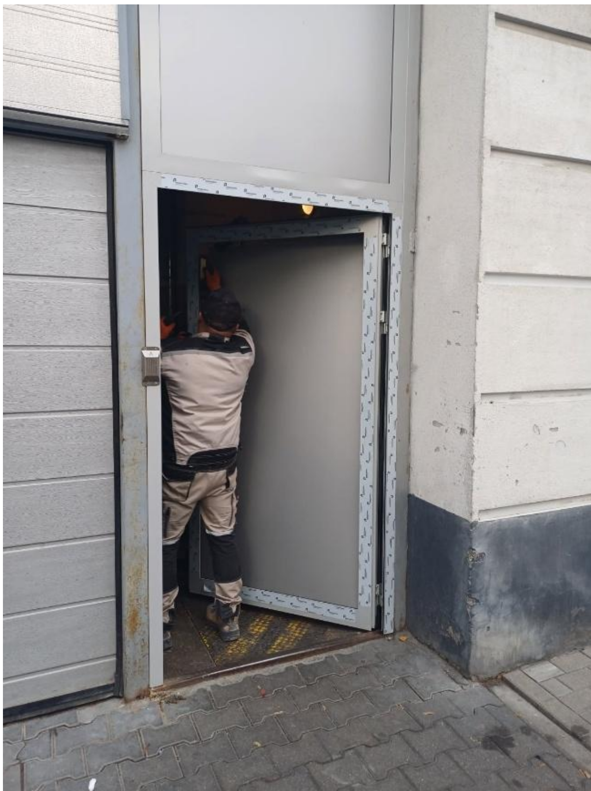
Al. Stanów Zjednoczonych 72 – wymiana panela z drzwiami do komory śmietnikowej
