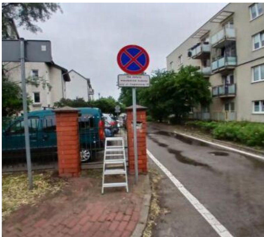
Montaż znaku dotyczącego parkowania na parkingu należącym do bloku Cegielniana 15.
