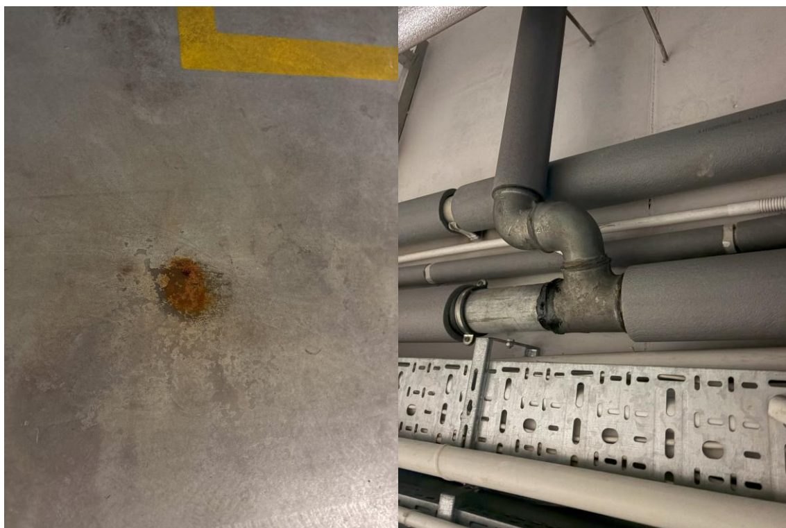
Komorska 11/15 – wymiana przeciekających zaworów podpionowych w garażu
