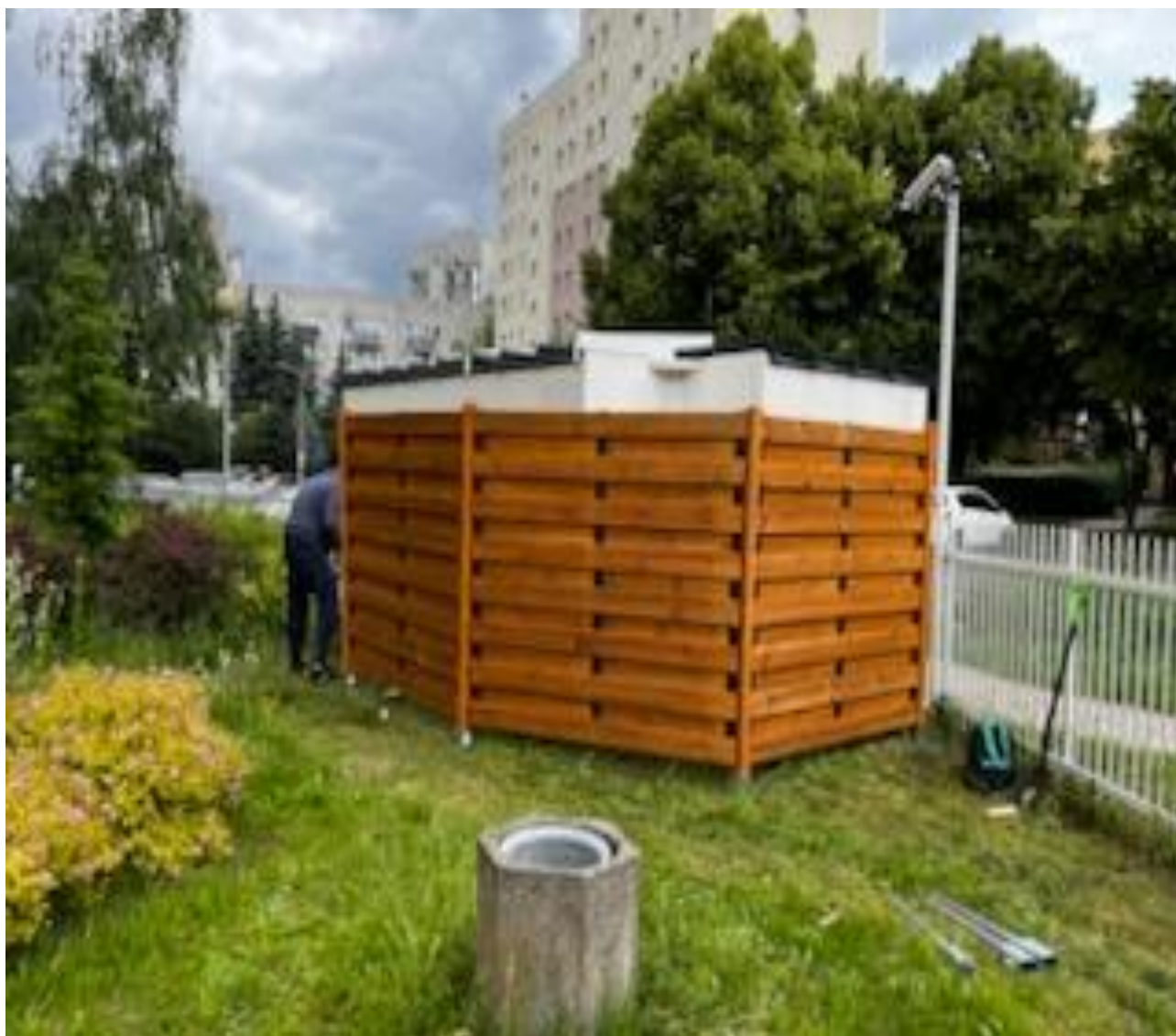
Zabudowa paczkomatu od strony balkonów drewnianymi przesłami przy bloku Pileckiego 108.
