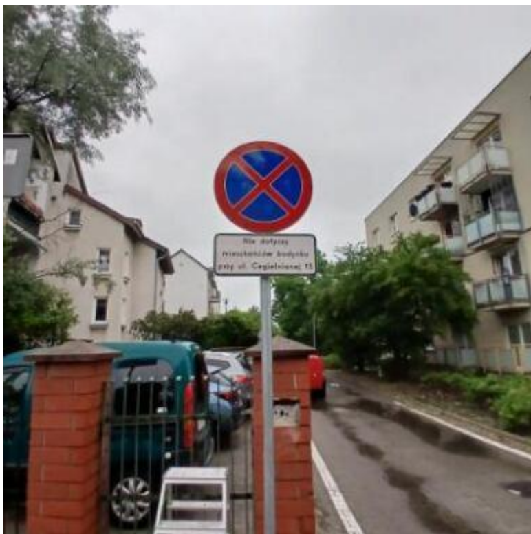
Montaż znaku dotyczącego parkowania na parkingu należącym do bloku Cegielniana 15.
