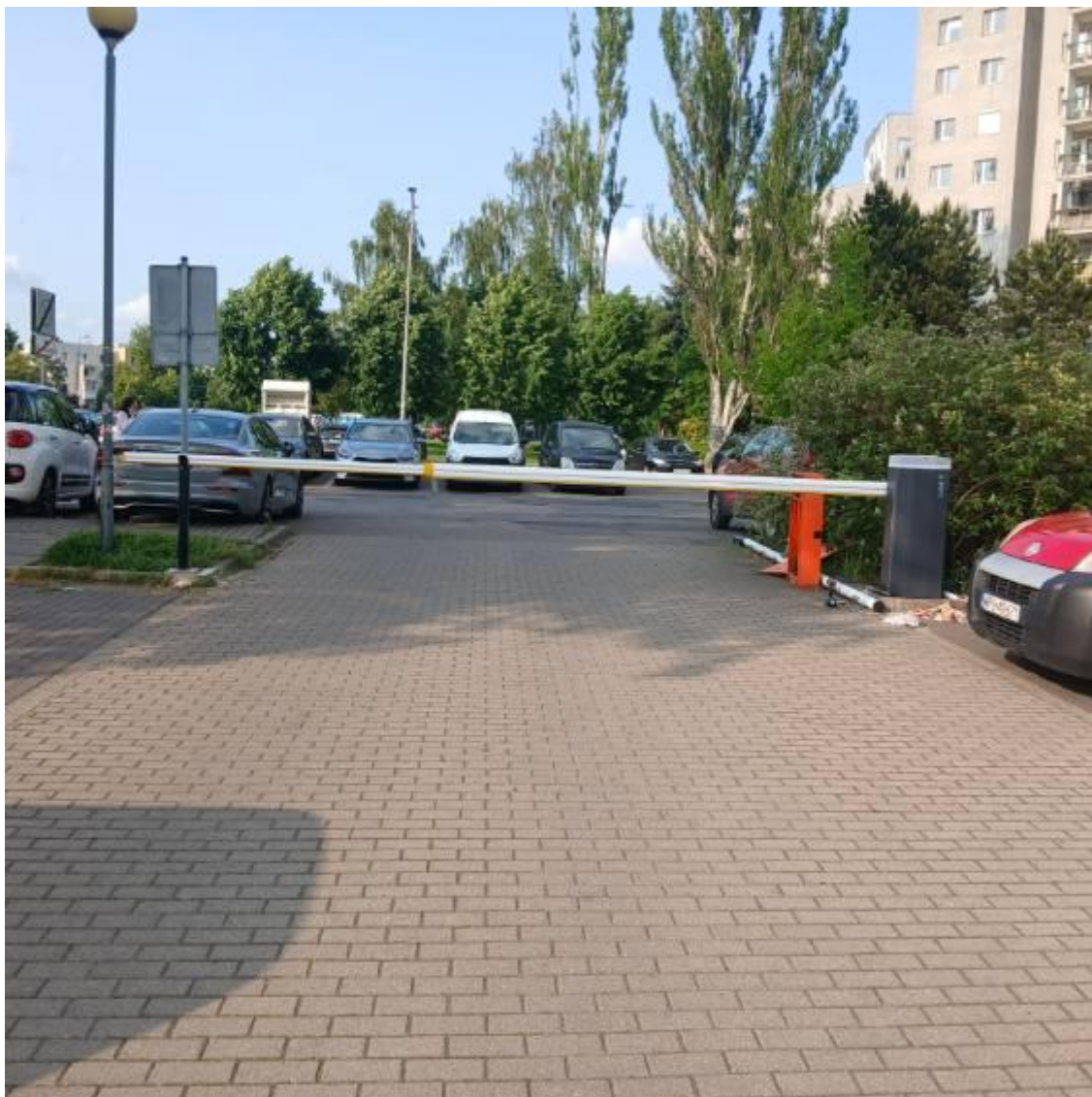
Montaż nowego szlabanu na osiedlu Pileckiego 104,106,108
