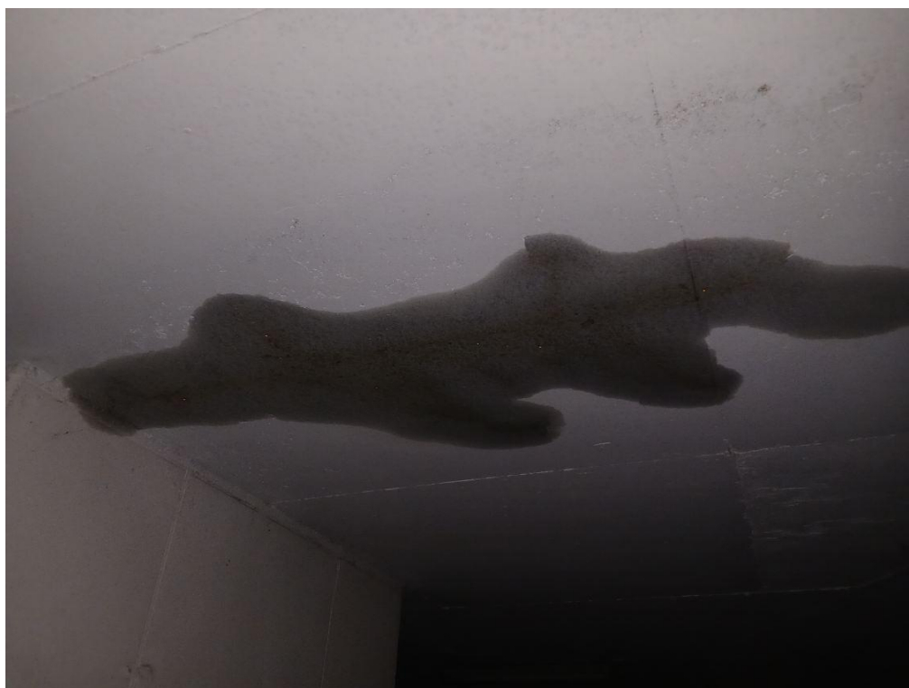
Al. Stanów Zjednoczonych 72 – wyciek oleju z dźwigu panoramicznego
