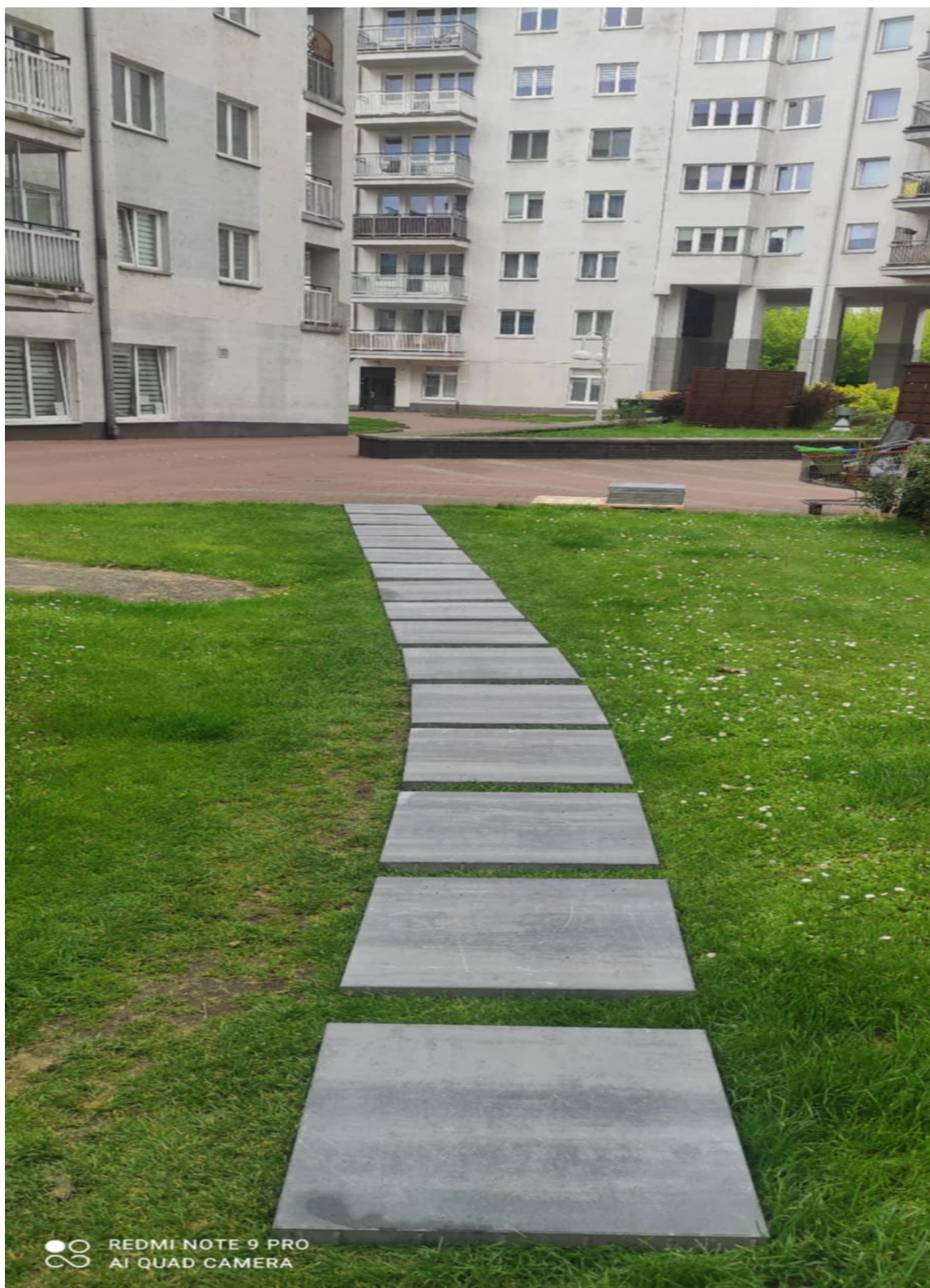
Przygotowanie -wymierzenie pod nowy chodnik z płyt lokalizacja Stryjeńskich 19.
