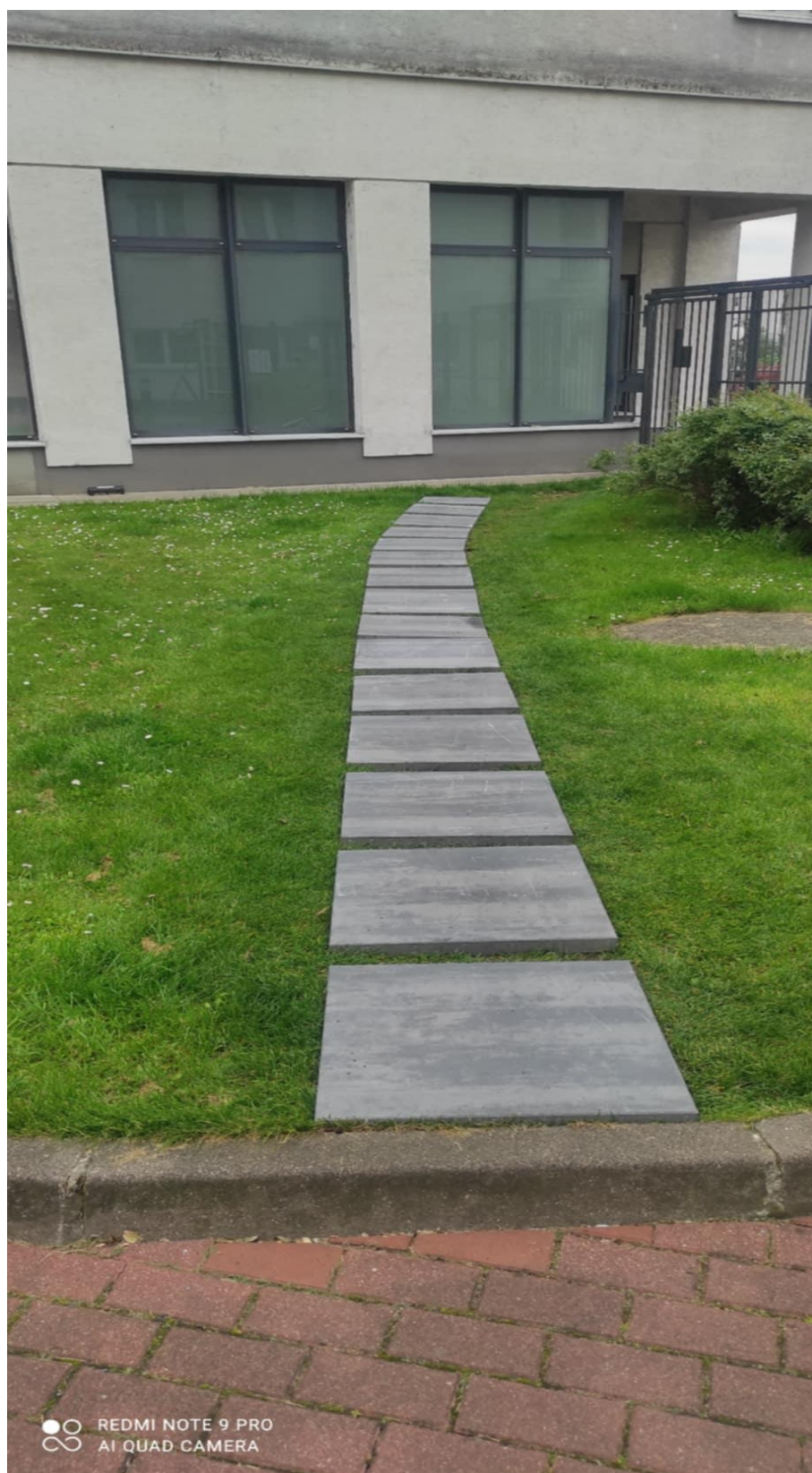
Przygotowanie -wymierzenie pod nowy chodnik z płyt lokalizacja Stryjeńskich 19.
