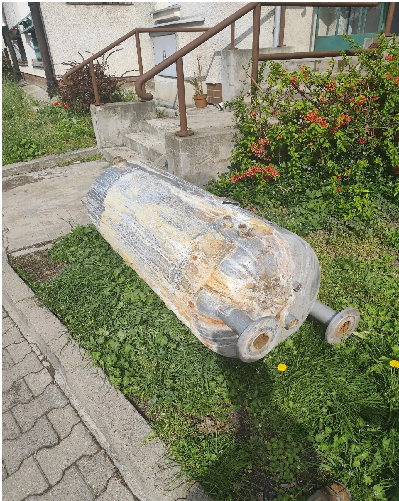
Wymiana – modernizacja zbiornika w węźle ciepłowniczym na nieruchomości Cegielniana 15 Pruszków.
