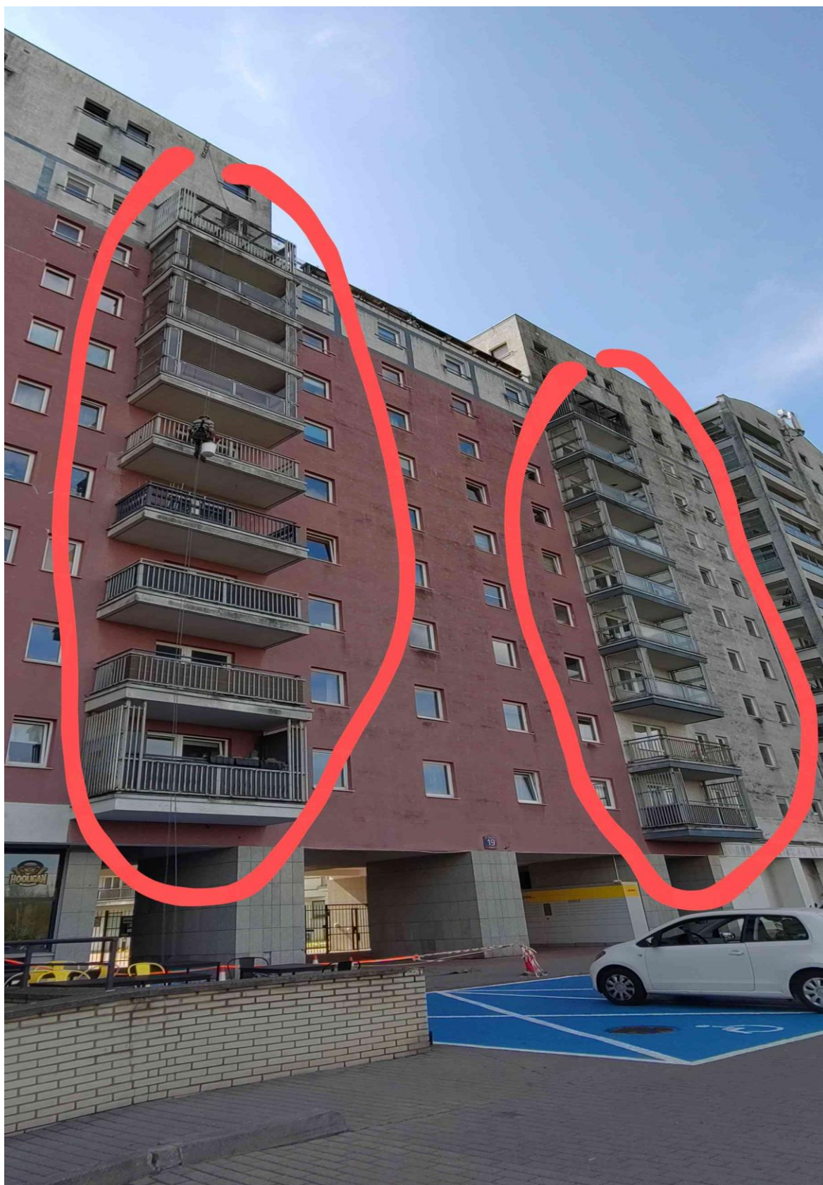
Prace alpinistyczne na osiedlu Stryjeńskich 19 -oczyszczenie balkonów z odpadającego betonu .
