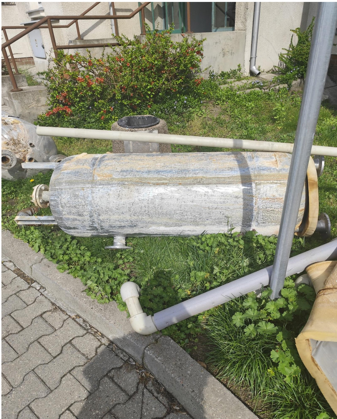
Wymiana – modernizacja zbiornika w węźle ciepłowniczym na nieruchomości Cegielniana 15 Pruszków.
