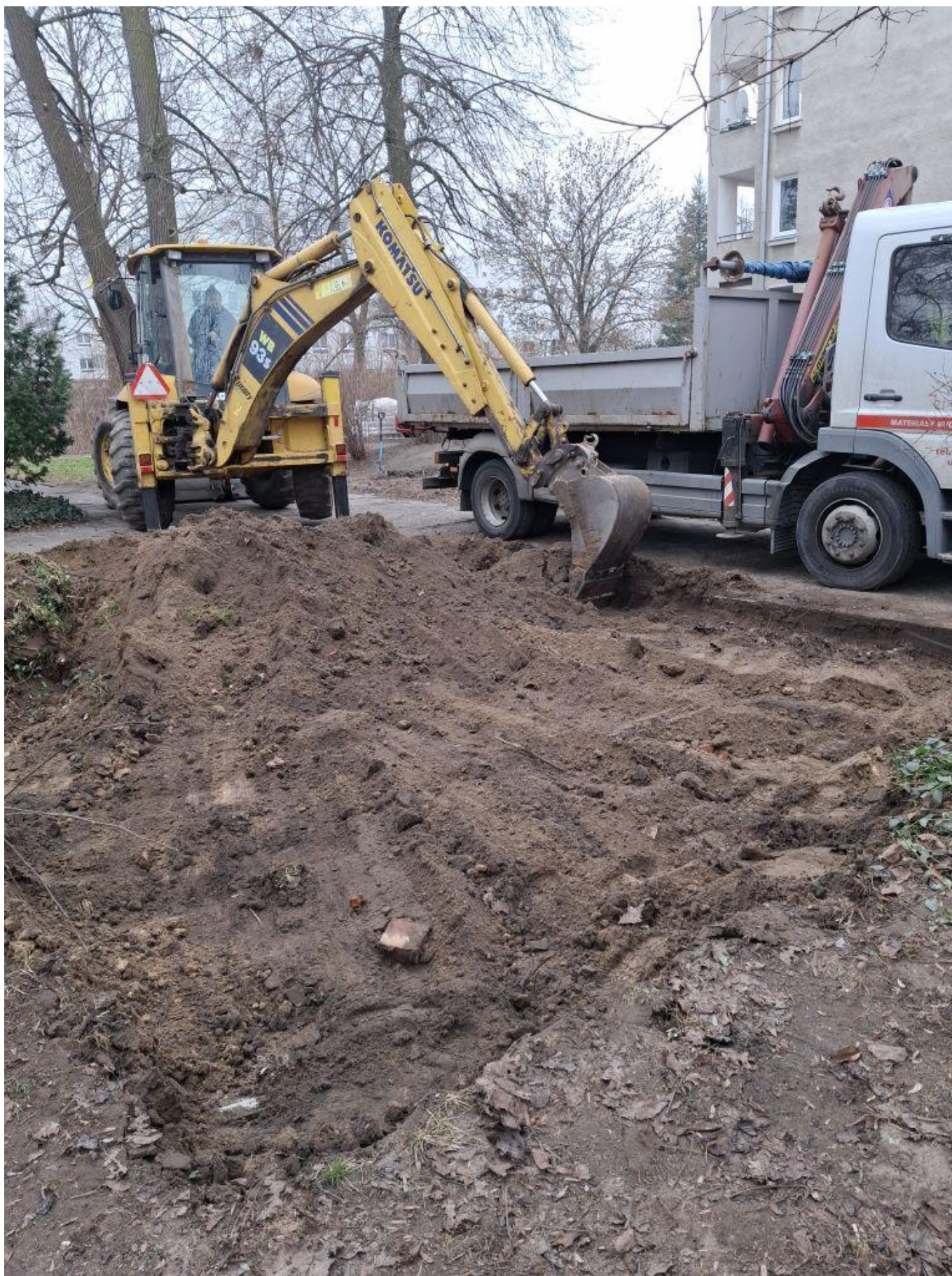
Rozpoczęte prace budowlane – parking na terenie nieruchomości Lipowa 38
