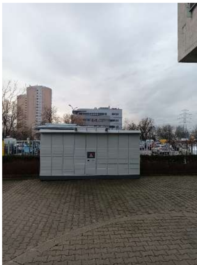
Komorska 11/15 – montaż paczkomatu ORLEN
