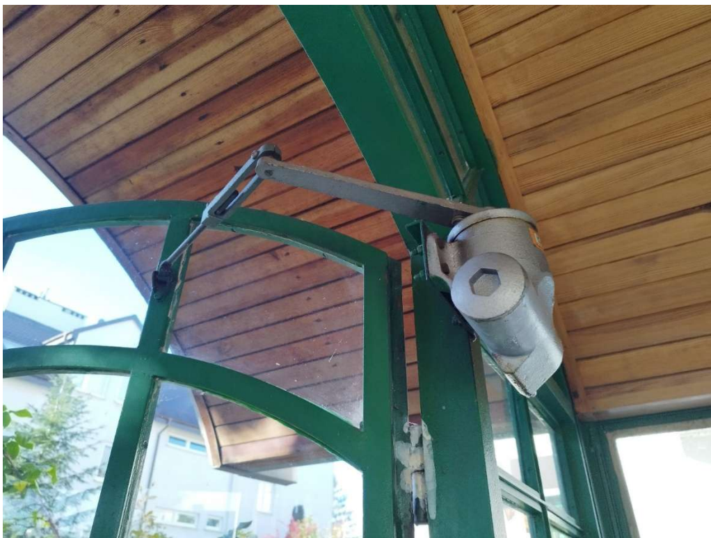
Wymiana siłowników w drzwiach wejściowych na klatki schodowe Cegielniana 15 , Pruszków
