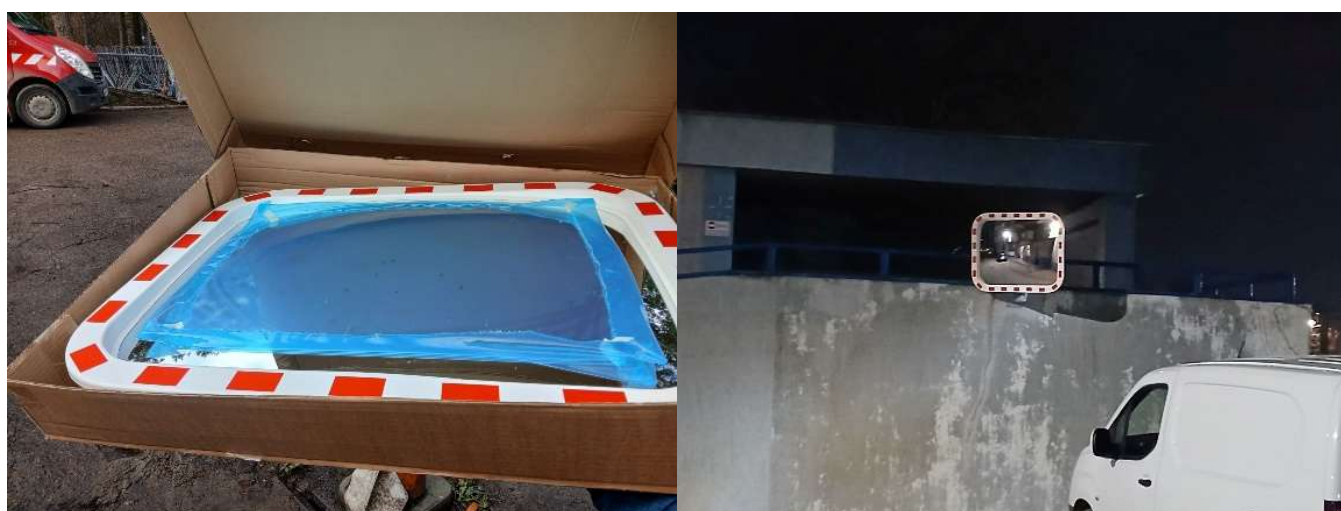
Bitwy Warszawskiej 1920 r. nr 18 – dostawa i montaż nowego lustra drogowego
