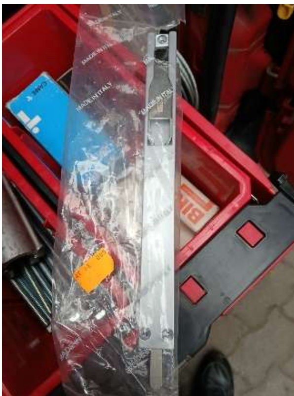
Bitwy Warszawskiej 1920 r. nr 18 – wymiana uszkodzonego rygła w drzwiach wejściowych do IV klatki schodowej
