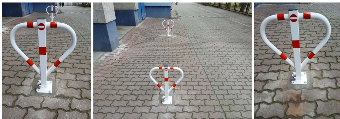
Bitwy Warszawskiej 1920 r. nr 18 – montaż nowych blokad parkingowych
