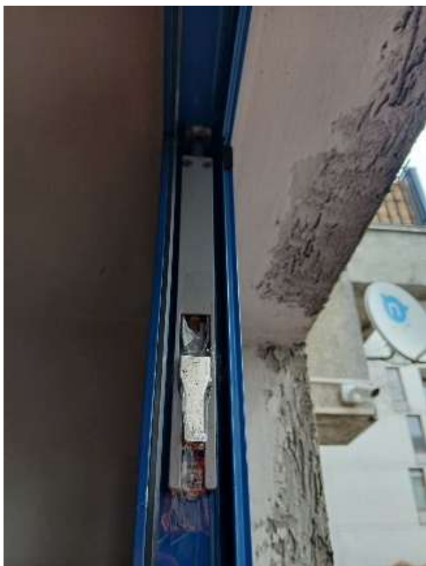
Bitwy Warszawskiej 1920 r. nr 18 – wymiana uszkodzonego rygła w drzwiach wejściowych do IV klatki schodowej
