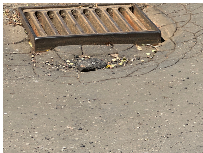
Rzymowskiego 33 – studzienka do naprawy na wprost VI klatki schodowej
