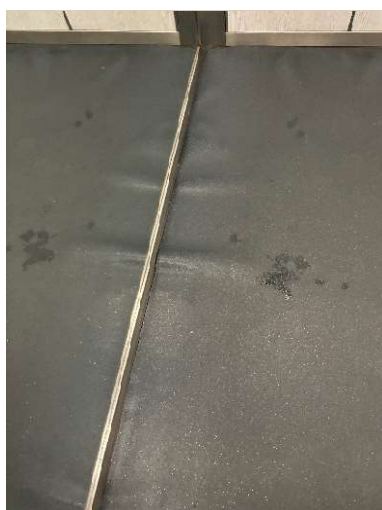
Rzymowskiego 19 – I klatka schodowa – wykładzina w dźwigu osobowym
