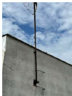
Osiedle przy ul. Jadźwingów 1, ul. Jadźwingów 3, ul. Rzymowskiego 33 – dach – konieczność remontu mocowań stopni – schodów na dachach
