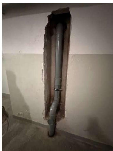
Jadźwingów 1 – zabudowa dwóch pionów kanalizacji deszczowej po ich wymianie
