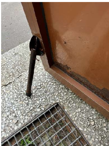
Jadźwingów 3 – wymiana stopki w drzwiach wejściowych do III klatki schodowej
