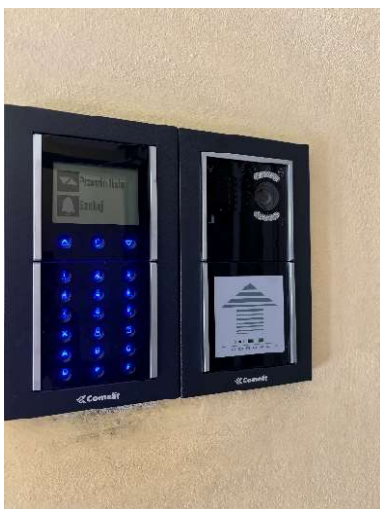
Rzymowskiego 19 – montaż nowego panelu domofonowego w II klatce schodowej
