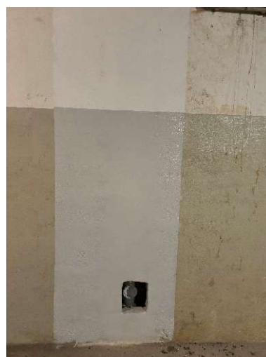
Jadźwingów 1 – zabudowa dwóch pionów kanalizacji deszczowej po ich wymianie
