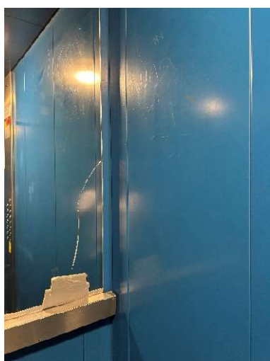
Jadźwingów 1 – zabudowa dwóch pionów kanalizacji deszczowej po ich wymianie
