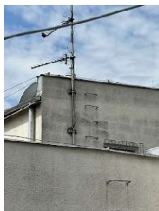
Osiedle przy ul. Jadźwingów 1, ul. Jadźwingów 3, ul. Rzymowskiego 33 – dach – konieczność remontu mocowań stopni – schodów na dachach
