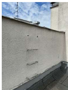
Osiedle przy ul. Jadźwingów 1, ul. Jadźwingów 3, ul. Rzymowskiego 33 – dach – konieczność remontu mocowań stopni – schodów na dachach
