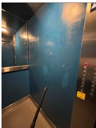
Bitwy Warszawskiej 1920 r. nr 18 – kabina dźwigu do malowania, pęknięte lustro do wymiany
