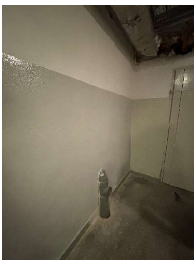
Jadźwingów 1 – zabudowa dwóch pionów kanalizacji deszczowej po ich wymianie
