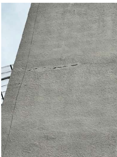
Rzymowskiego 33 – pęknięcie elewacji nad I klatką schodową
