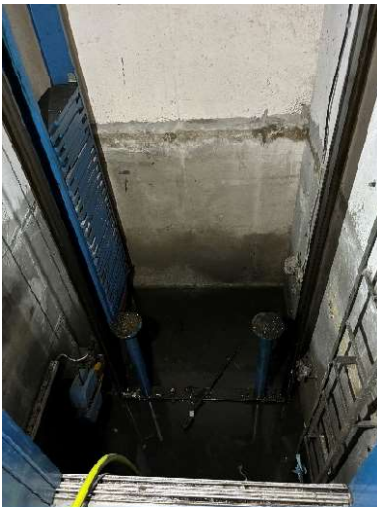
Bitwy Warszawskiej 1920 r. nr 18 – 2 klatka schodowa – zalanie szachu dźwigu osobowego, zalanie piwnic
