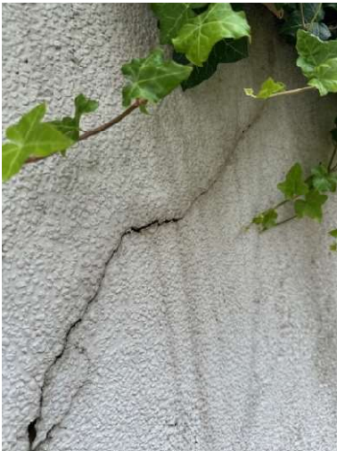
Jadźwingów 3/23 – spękania części elewacji
