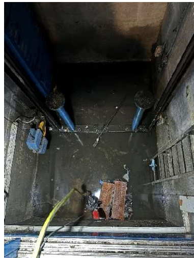
Bitwy Warszawskiej 1920 r. nr 18 – 2 klatka schodowa – zalanie szachu dźwigu osobowego, zalanie piwnic
