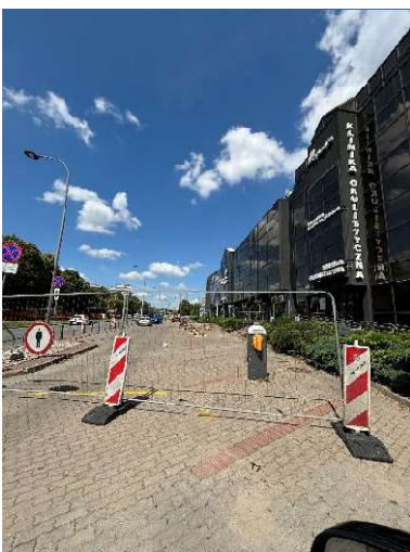
Bitwy Warszawskiej 1920 r. nr 18 – rozpoczęcie budowy zaplecza placu budowy linii tramwajowej wzdłuż ulicy Bitwy Warszawskiej 1920 r.
