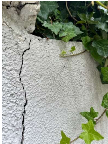
Jadźwingów 3/23 – spękania części elewacji
