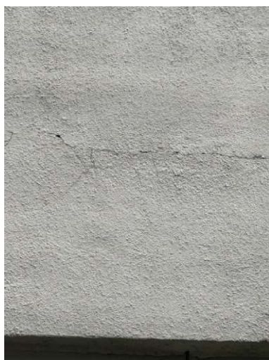
Rzymowskiego 33 – pęknięcie elewacji nad I klatką schodową
