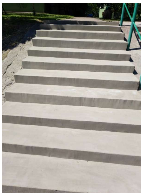
Schody po remoncie
